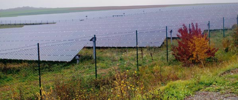
Ökostrom: Löb produziert Strom aus Sonnenenergie
